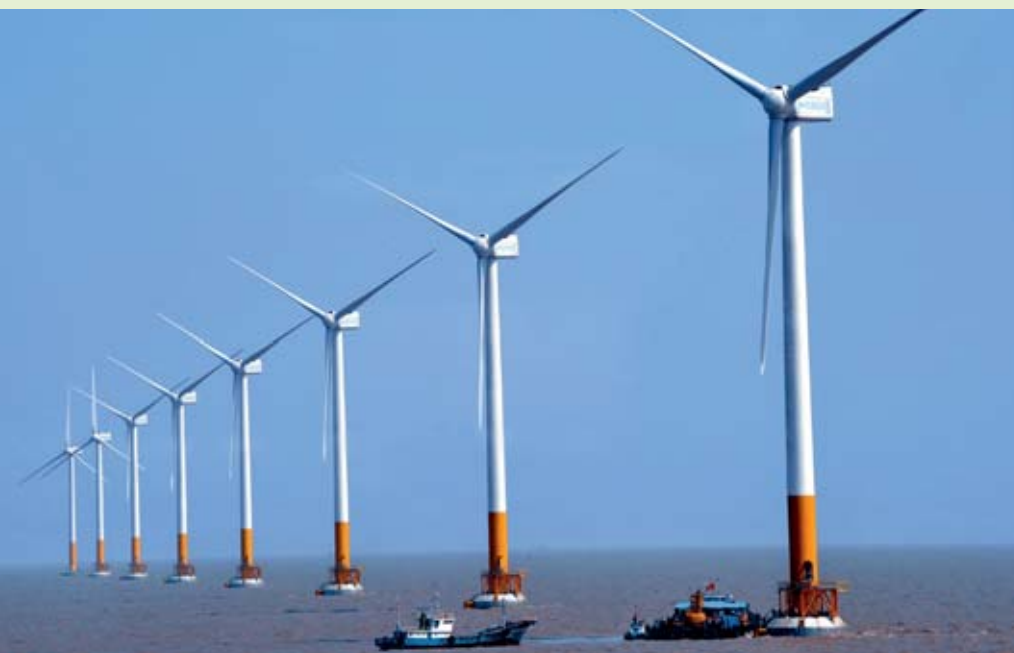
Der Bedarf an Windkrafttechnik in China – hier der Hochseewindpark in Donghai – ist riesig. Jede zweite Windturbine wird in der Volksrepublik aufgestellt.
