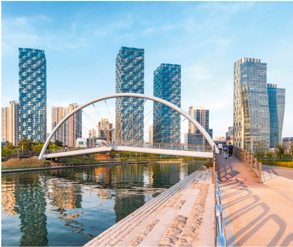
Viel Technik und Infrastruktur aus einem Guss: Songdo, ein Stadtteil der südkoreanischen Millionenstadt Incheon, gilt weltweit als Vorzeigeprojekt, wenn es um die Smart City geht.
